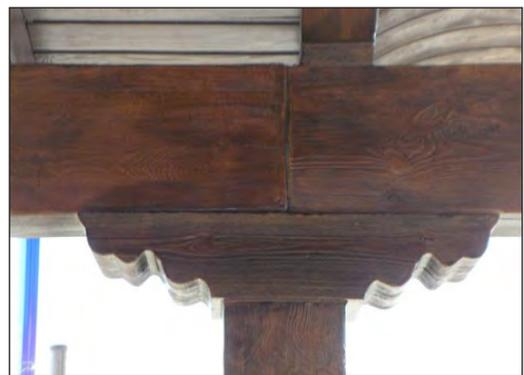
Con las primeras estructuras de madera, y para mejor acomodo de unas vigas que podían flexionar y desajustarse en su apoyo si este era de escasa superficie, pudo ser constructivamente conveniente aumentar esa superficie con un elemento intermedio.
